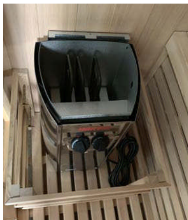
Instalovaný rám. Kamna instalujte dle návodu pro daný typ kamen.
